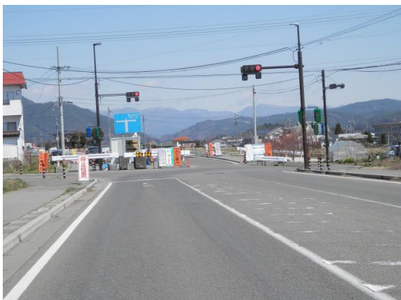
4/6 時点・信号機設置
