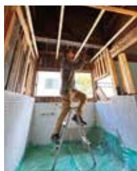
お風呂を解体して トイレを作っています
