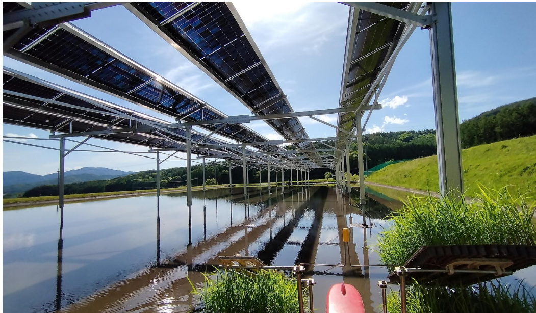
水稲のソーラーシェアリングの写真(茅野市)
