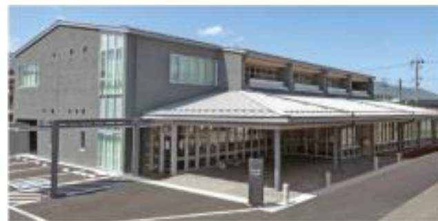
← 箕輪町初のZEB施設 防災交流施設 みなのわBASE
