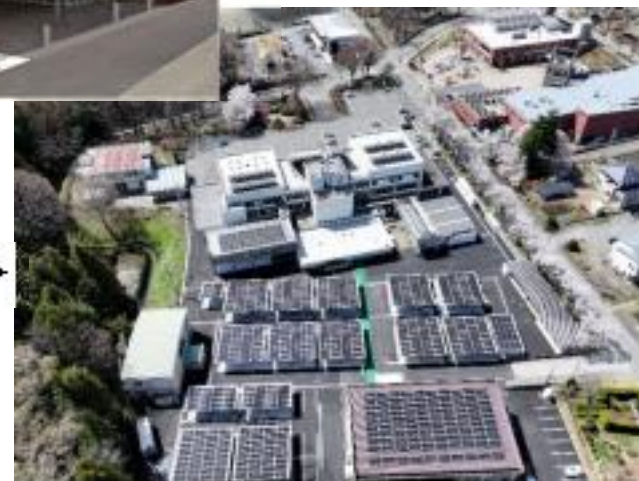
役場庁舎周辺再エネ整備事業 みなのわサステナブルエネルギーPG （MSPG）
