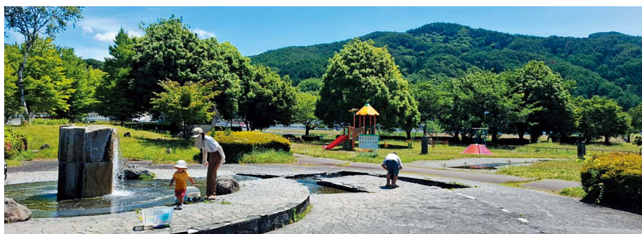
老朽化が進む天竜公園
