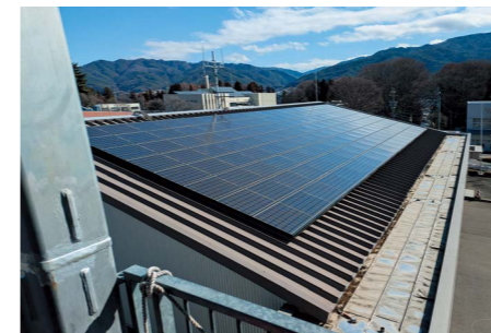
太陽光改修した地域交流センター
