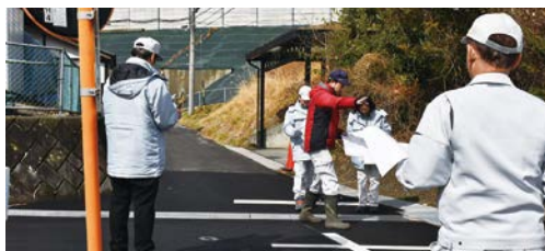
雨水基幹水路接続(沢・保育園北)
