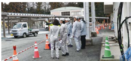
役場裏駐車場太陽光発電設備工事
