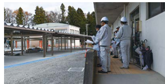
役場庁舎北側駐車場ソーラーカーポート整備現場
