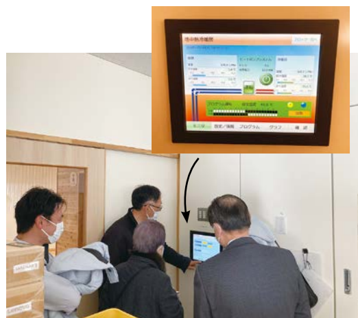
木下保育園 地中熱暖房運用状況
