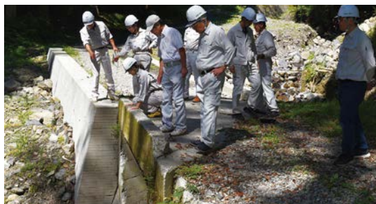
下古田 北の沢川災害復旧現場
