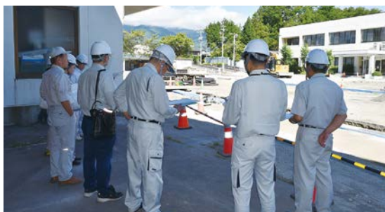
役場庁舎裏駐車場 ソーラーカーポート設置工事
