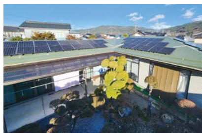
パネル25枚発電量9.6kwの 屋根上太陽光発電設備
