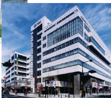
伊那市再開発ビルいなっせ 竹腰工業所施工実績 2002 年 ▶
