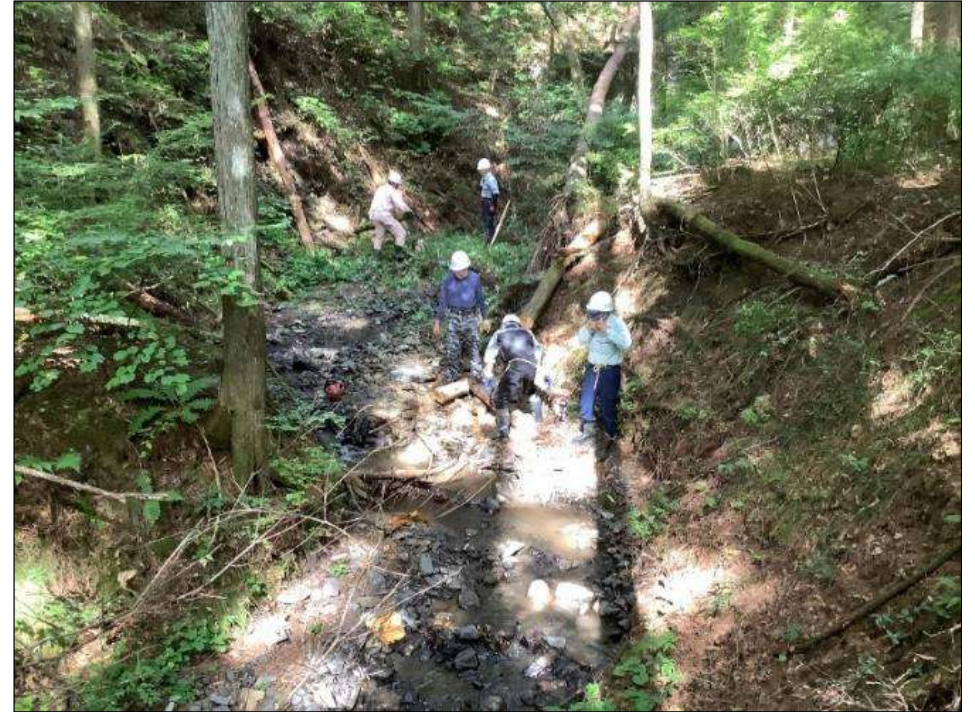
住民による撤去作業
