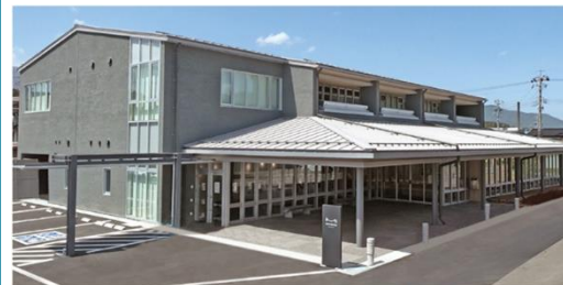
◀ 箕輪町初のZEB施設 防災交流施設 みのわBASE
