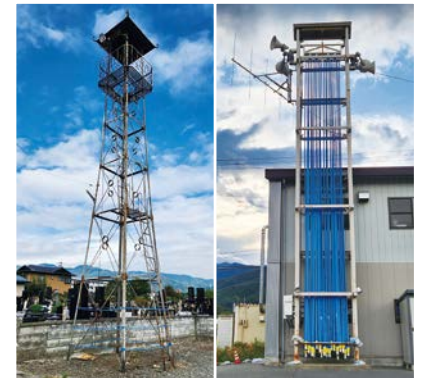
⑤松島坂井の撤去要望が出ている火の見やぐら ⑥消防ホースの乾燥と防災行政無線の取付けのみに変わった塔
