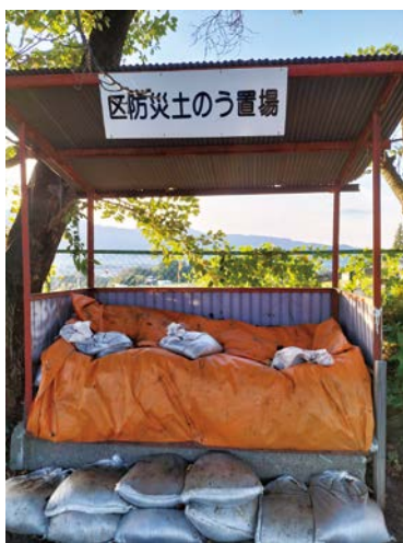
福与区 防災土のう置き場
