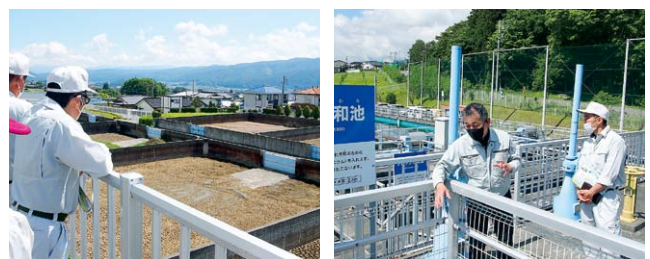
上伊那広域水道用水企業団「箕輪浄水場」
