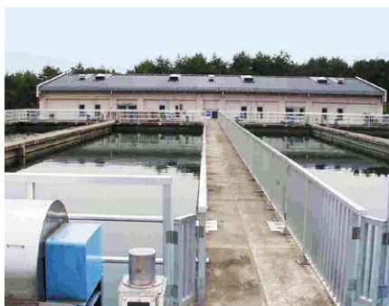
上伊那広域水道用水企業団の箕輪浄水場
