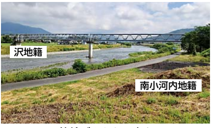
箕輪ダムからの水を 長田の箕輪浄水場へ送る「天竜川水管橋」
