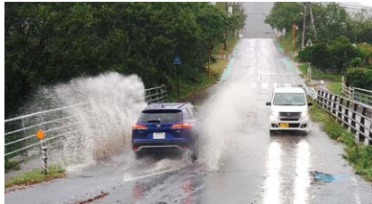
橋が冠水し通学路に水しぶきがかかる西県道・昭和橋
