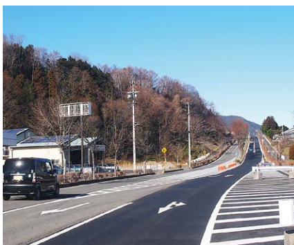
供用開始した国道バイパス交差点
