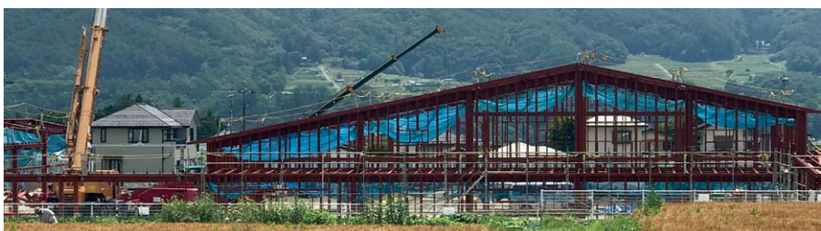
建設中の新木下保育園
