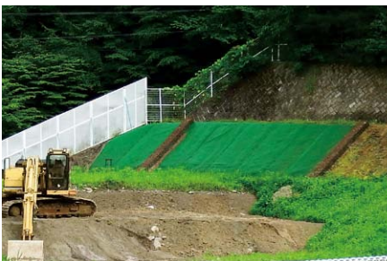
遮水シートを入れてある最終処分場
