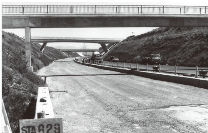
中央自動車道工事（昭和49年頃）
