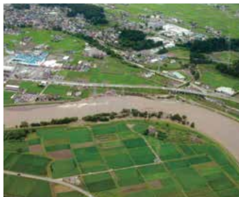
集中豪雨により決壊寸前の天竜川 (平成18年7月)
