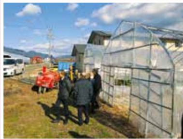
一部損傷したビニールハウス
