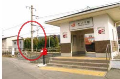
▲ 木ノ下駅公衆便所の建設予定地
