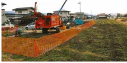
▲ 工事はじまる木下保育園現場
