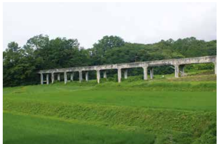
▲ 八乙女の水路橋
