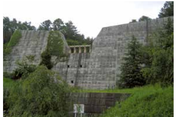
▲ 中の沢砂防えん堤 (平成18年7月 中の沢土石流災害後設置)
