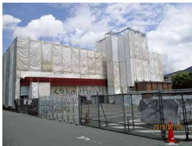
▲ 解体中のJA上伊那箕輪支所
