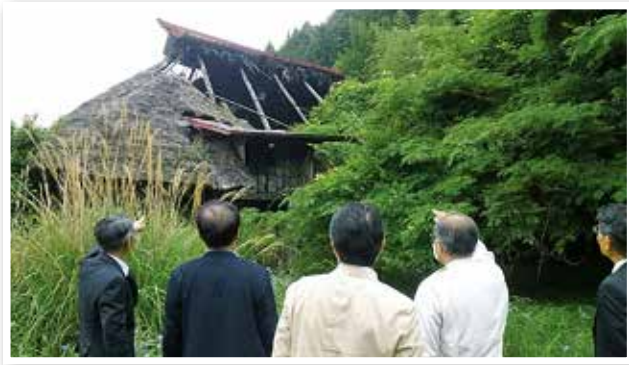
空き家の現地調査
