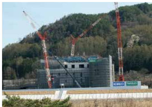
▲ 建設中の中間処理施設
