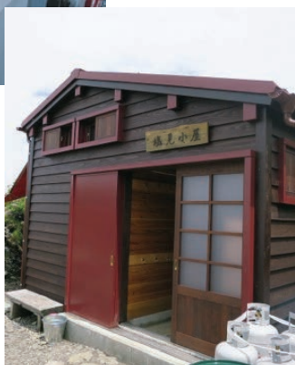
塩見小屋 ▶ (山頂において約 2 年かけて施工しました)
