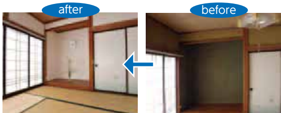
↓床の間や障子の上の小壁は、暗い色の砂壁でしたが、上から白い珪藻土を塗って、補修とイメージチェンジを実施
