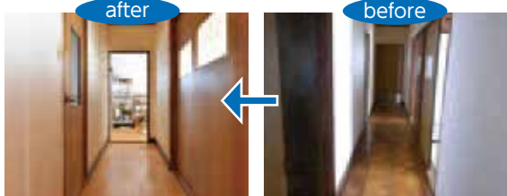
↑劣化しつつある床にウッドカーペットを敷き詰め、明るい印象に変身
