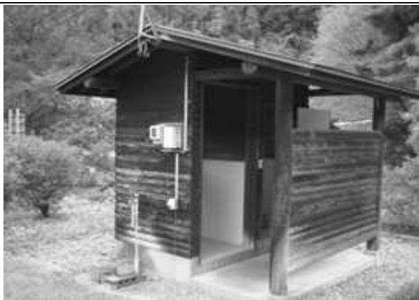
211 箕輪ダム周辺公園 トイレ（原石山）現状写真
