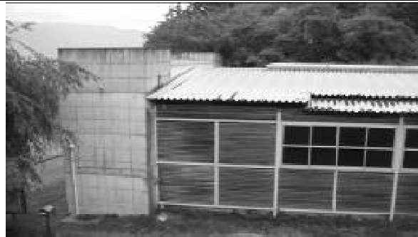
139 大出コミュニティセンター 屋根シート防水劣化状況
