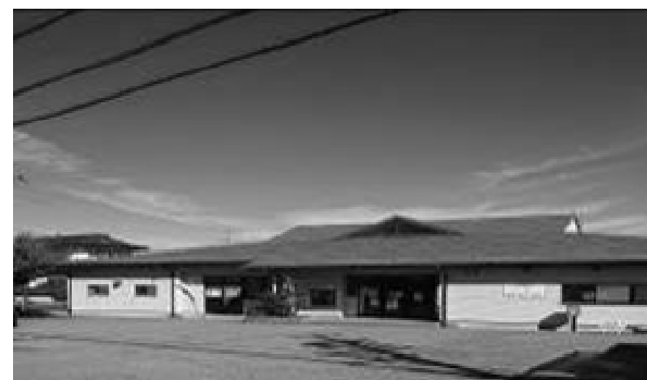
138 北西部多目的センター 全景
