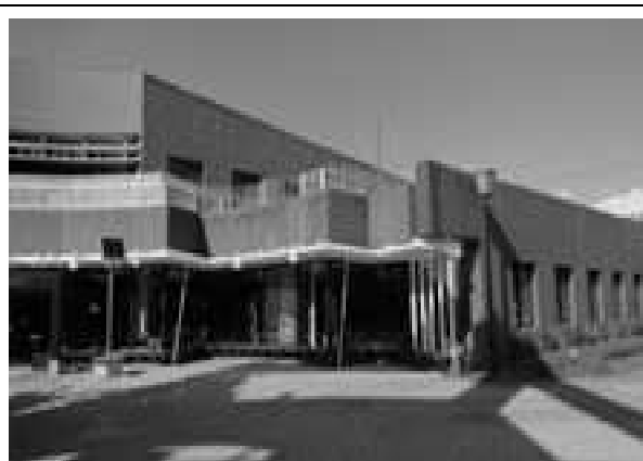
南側外部状況
