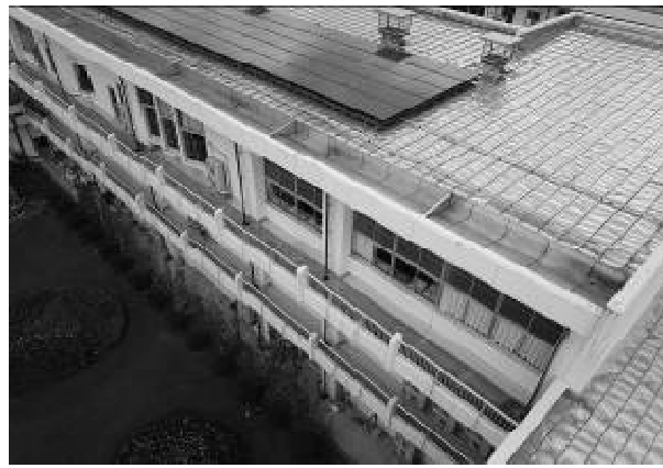
第3棟屋根状況
