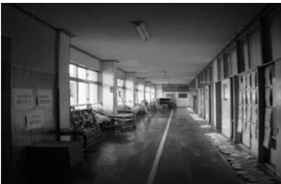
教室棟内部状況
