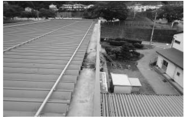
管理教室棟屋根・樋
