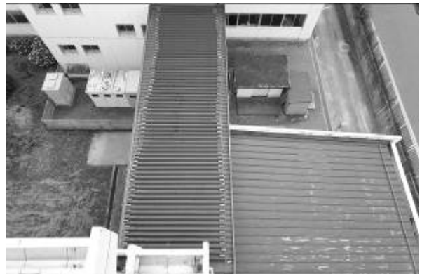
渡り廊下屋根状況
