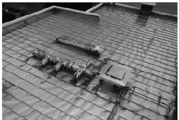
第 2 棟高架水槽撤去跡
