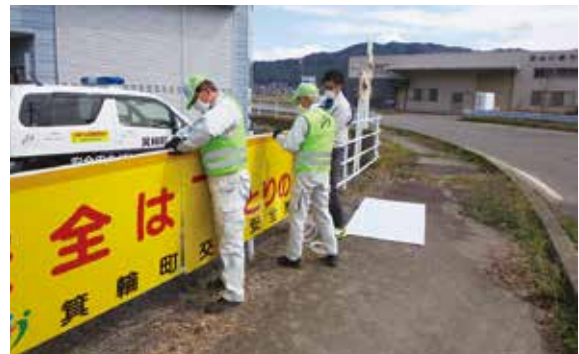
交通安全啓発看板の修繕、新設
