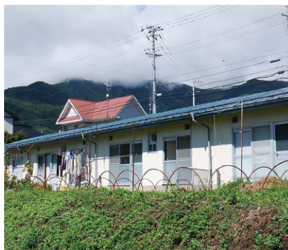
バリアフリー化されていない町営住宅
