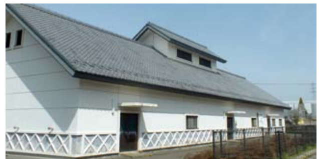
整備される旧中原農業集落排水処理施設
