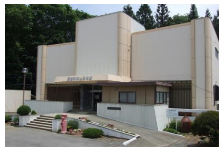
改修前の博物館
