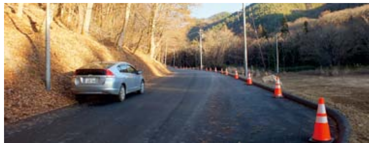
拡幅工事中的もみじ湖への県道
