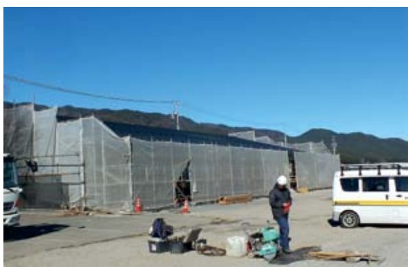
みのわテラス、工事中の直売所
