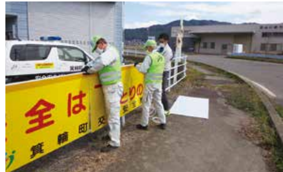
交通安全啓発看板の修繕、新設
