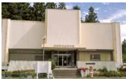
▲ 耐震診断を実施している郷土博物館
