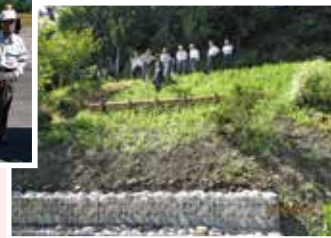
改修後の崩落現場
