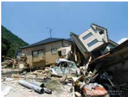
▲ 西日本豪雨の被災状況 (出典：一般財団法人消防防災科学センター「災害写真データベース」より)
