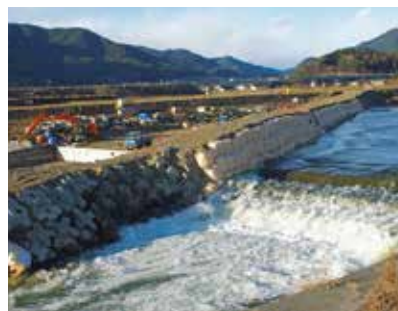
▲ 天竜川上河原井頭首工
