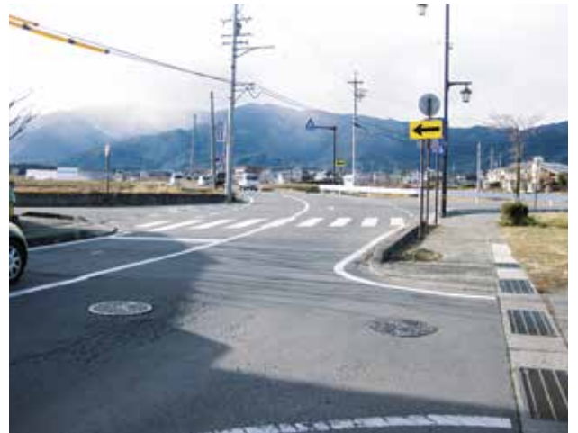
▲ 町道4号・8号線の変則交差点
