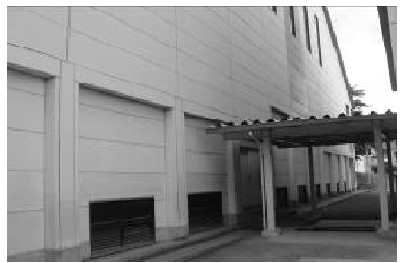
外壁東面の状況
