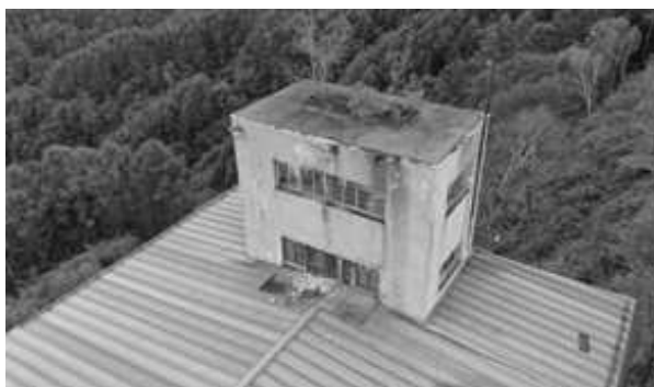
本館棟 外部の状況
