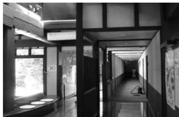
中央棟から東棟方向 内部の状況
