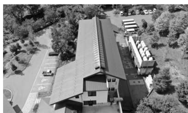
西棟 屋根の状況
