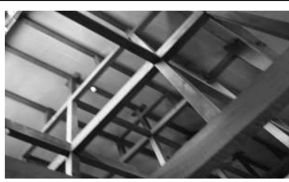
エントランスホール 内部天井の状況
