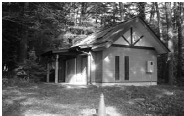
200 トイレ H26 改築(外部)
