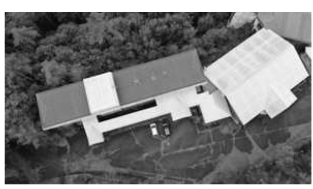
宿泊棟(左)とレストハウス(右)の屋根の状況
