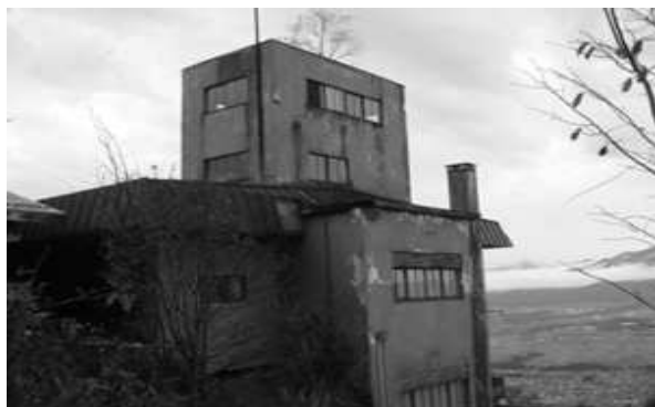
本館棟 外部の状況
