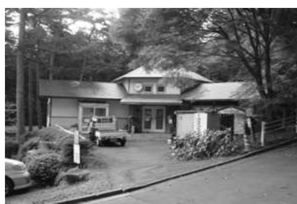
187 管理棟 H26 改修工事実施
