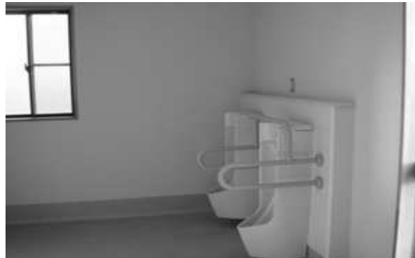
200 トイレ H26 改築(内部)
