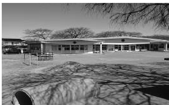
南面外部状況
