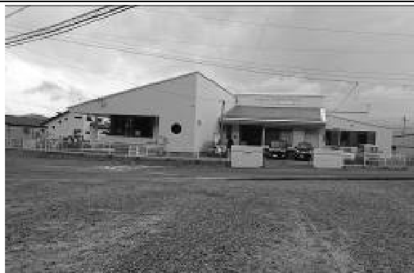
東面外部状況(大規模改修工事済)
