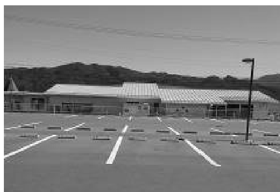
西面外部状況
