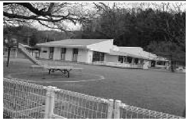
外部状況（大規模改修工事済）
