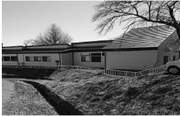
北面外部状況（大規模改修工事済）
