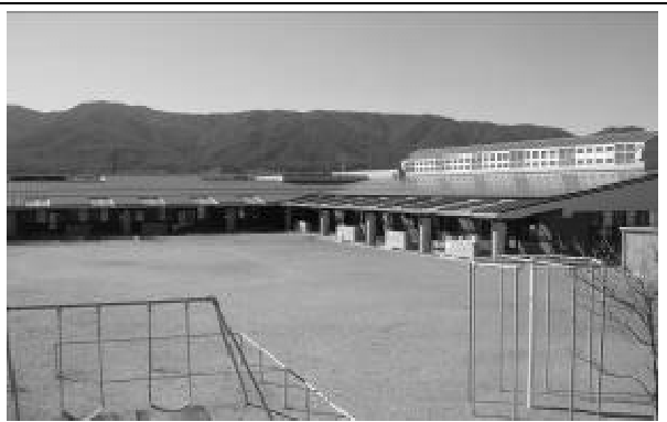
南東面外部状況
