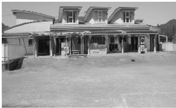
南面外部状況
