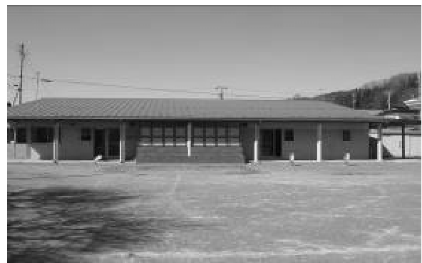
南面外部状況
