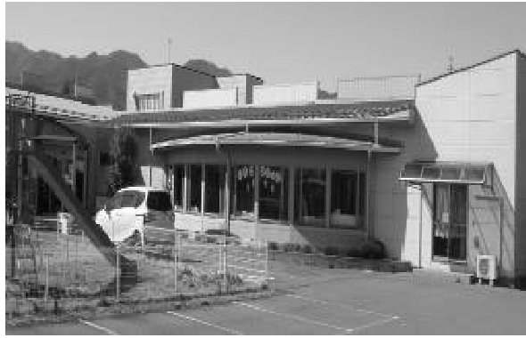
南面外部状況(屋根・外壁大規模改修済)
