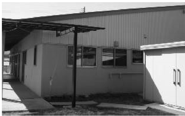
東面外部状況
