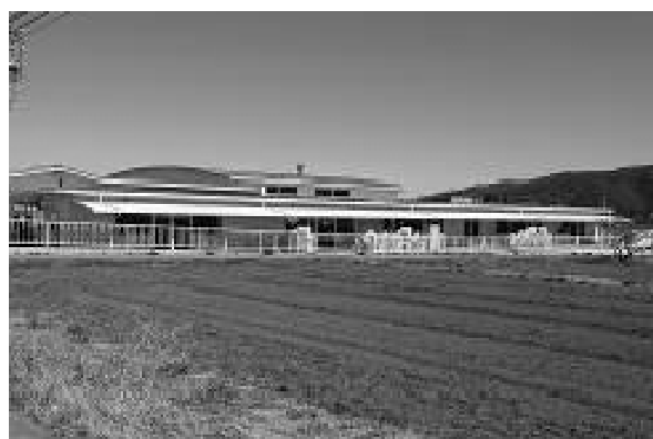
南面外部状況
