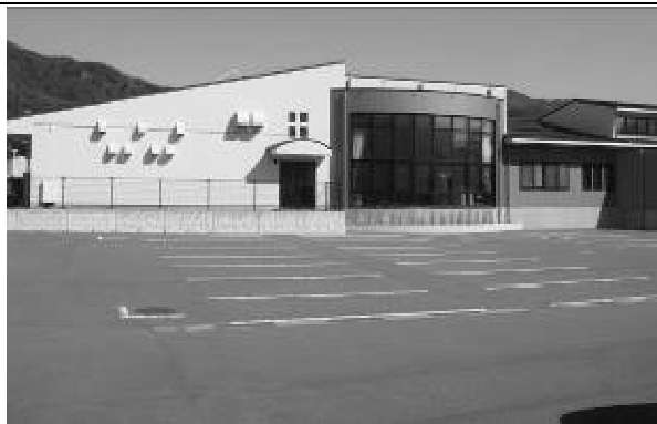
西面外部状況
