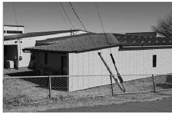
増築部分外部状況（大規模改修工事済）
