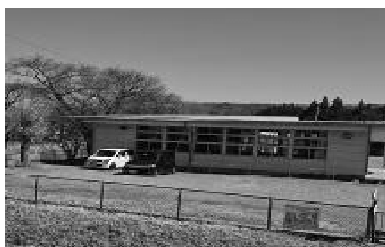
西面外部状況
