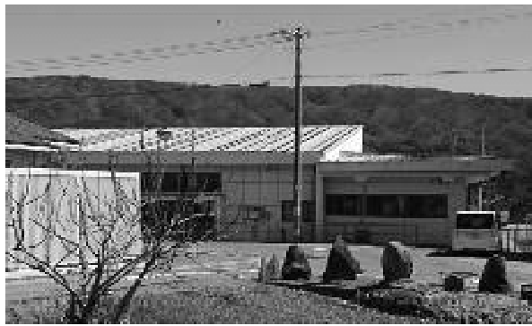
西面外部状況
