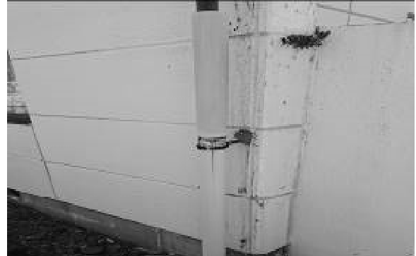
外壁 A L C 状況
