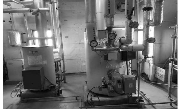
更新時期を迎えているボイラー
