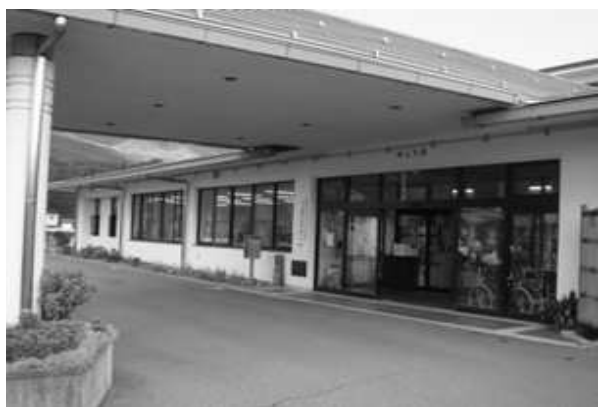
北側玄関外部状況
