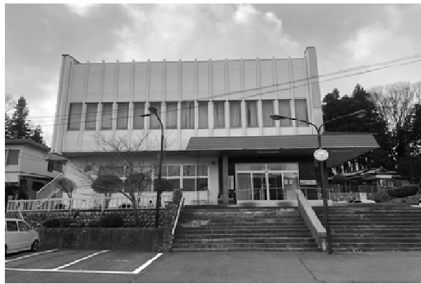
東側外部状況
