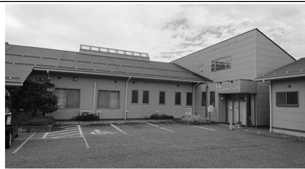
西側からの外部状況
