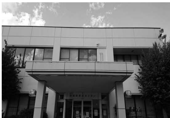
南側外部状況
