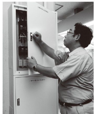
災害時など、いざという時に、充電した電気が使えるようになっています。
